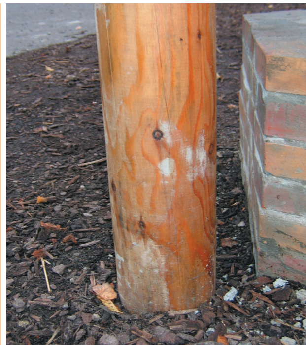
Grundingsolie er godt, men desværre ikke nok at til beskytte træ i jordkontakt.
